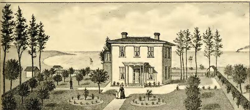
RESIDENCE OF F. W. BAKER Jr., SAN BUENAVENTURA, VENTURA CO. CAL.
